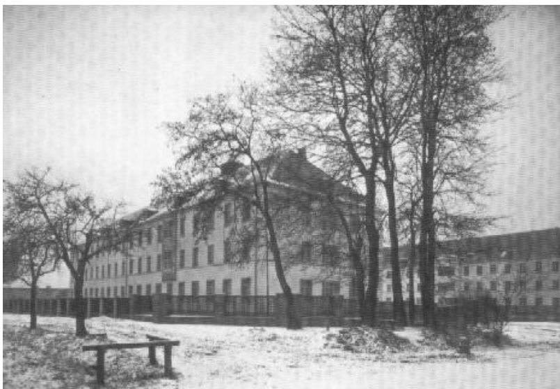
Mannschaftshäuser der Artilleriekaserne in Weende, um 1938, heute Weender Krankenhaus
