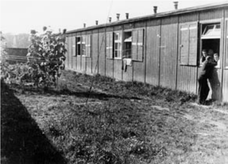
Abb. 1: Die Krankenbaracke am Ludendorffring 20 b (Sportfeld der Universität) – Aufnahme Stanislaw Goik, Zwangsarbeiter aus der Westukraine, der zunächst als Kohlenarbeiter und dann als Pfleger in der Krankenbaracke arbeitete. Obwohl es Polen und Ukrainern verboten war zu fotografieren, war es nach Aussage von Stan Goik (heute Australien) für ihn kein Problem, an einen Fotoapparat zu kommen. Schwierig war es dagegen, Filme zu beschaffen und die Entwicklung der Filme zu organisieren.
